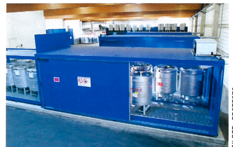
➌ Einige der Container zur passiven Lagerung brennbarer Flüssigkeiten sind mit Schiebetoren sowie einer automatischen Türschließenanlage mit Haftmagnet und mechanischem Torantrieb ausgerüstet.
